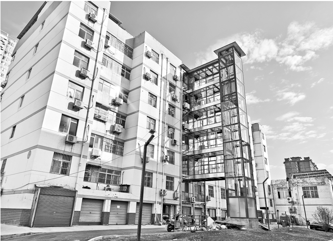
近年来，全市老旧小区改造持续推进。从屋面防水到外墙保温，从管网更新到路面硬化，从加装电梯到增设停车位，从补种绿植到完善照明，从整修楼道到加装扶手，每一项改造都瞄准居民最迫切的需求。改造后的老旧小区，不仅“面子”更靓，“里子”更实，更让居民的生活便利度、安全感、幸福感显著提升，真正实现了“改”到群众心坎上、“造”出生活新面貌，成为惠民暖民心的生动实践。图为新区某老旧小区内，工人正在进行电梯加装。 本报记者 郭雷摄
