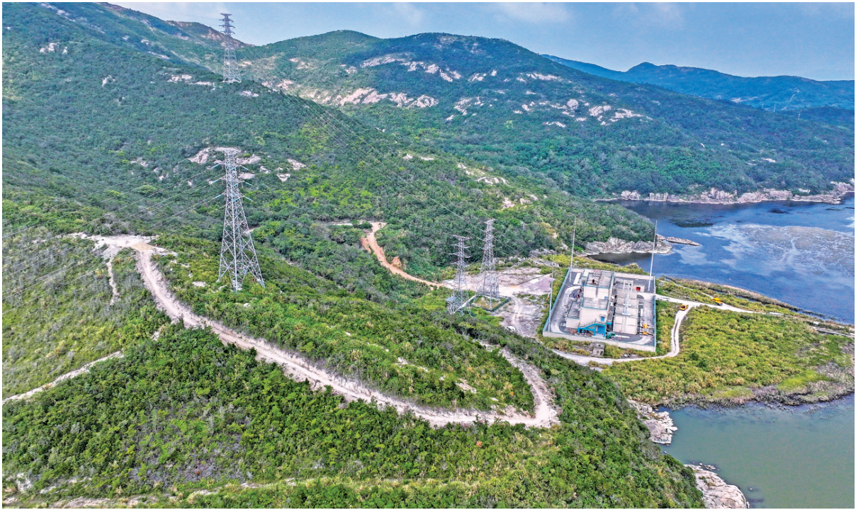
这是检修中的舟山岱山大长涂岛110千伏中柱变电站（9月21日摄，无人机照片）。
